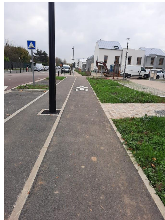
Luminaire sur le cheminement piéton
